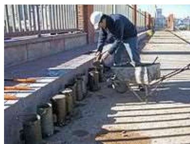
Figura B: Comprobación de la resistencia del hormigón
