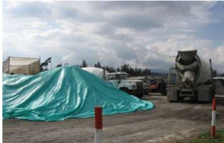
Figura 2.5 Planta Hormigonera de Napo Fuente: Empresa Napo (2015)
