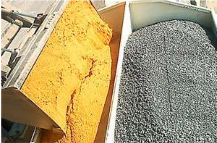
Figura 4.3: Cargar los agregados en la criba
