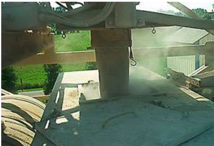
Figura 4.2: Cargar la tolva de cemento por silo en la planta de hormigón
