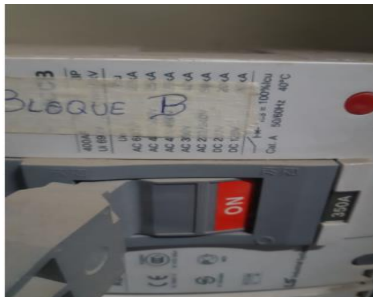
Figura C.4. Interruptor térmico secundario de distribución
