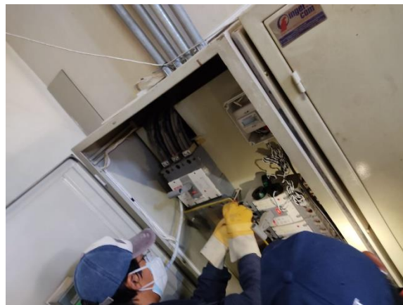
Figura F.5 Instalación del medidor inteligente
