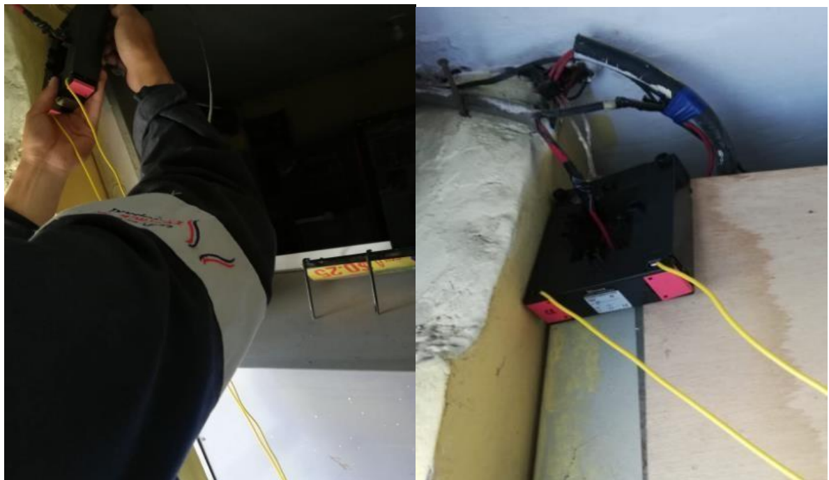
Fotografías. Colocación del transformador de corriente en cada una de las fases.
