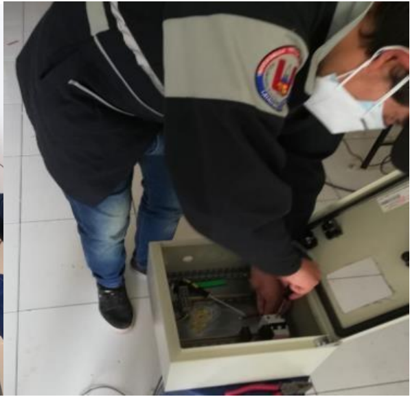
Fotografía 2. Colocación de los equipos dentro del gabinete metálico.
