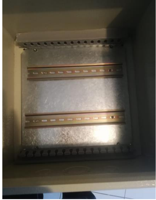
Fotografía 1. Perforaciones en el gabinete metálico para sujetar los materiales.
