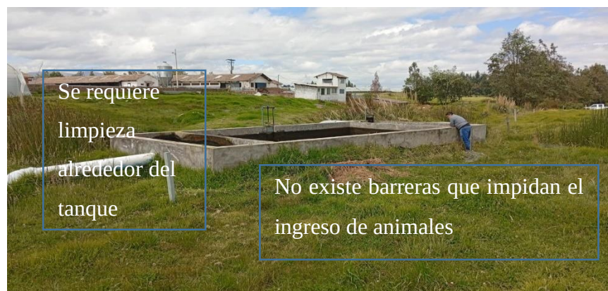
Fotografía 34: Exceso de vegetación en el tanque sedimentador
