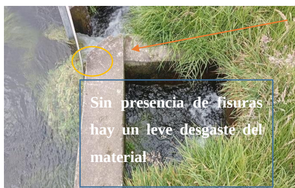
Fotografía 3: Sin presencia de fisuras hay un leve desgaste del material en la caja de recolección
