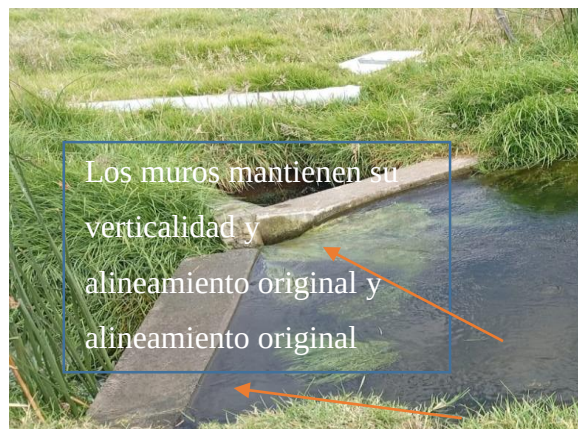
Fotografía 3: Sin presencia de fisuras hay un leve desgaste del material en la caja de recolección
