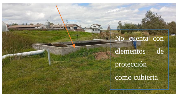
Fotografía 23:No presenta fallas estructurales en el tanque sedimentador
