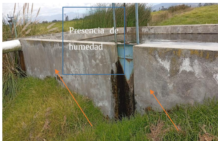
Fotografía 16: Presencia de humedad en el tanque
