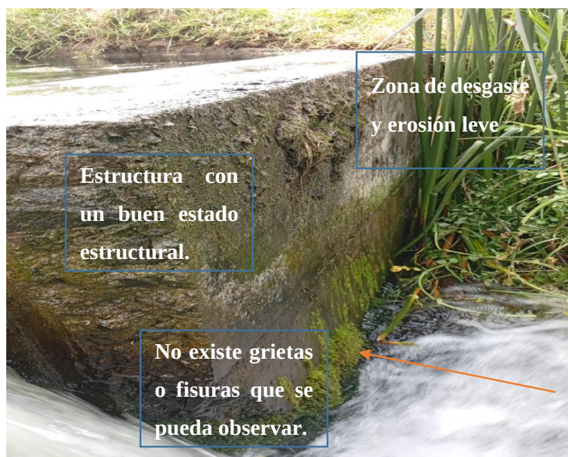
ANEXO 19: Fotografías de verificación de la matriz Vulnerabilidad Funcional de la obra de captación
