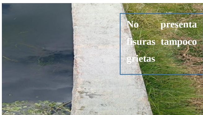
Fotografía 15: Muros estables, presenta desprendimiento del concreto
