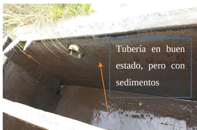
Fotografía 22:No dispone de cubierta, no cuenta con cerramiento
