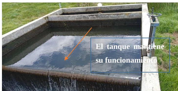
Fotografía 30:El tanque continúa operando con incremento de sedimentos y vegetación acuática
