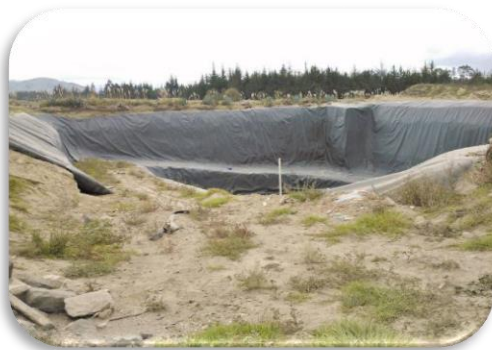
Fotografía N° 5 Lugar de trabajo relleno
