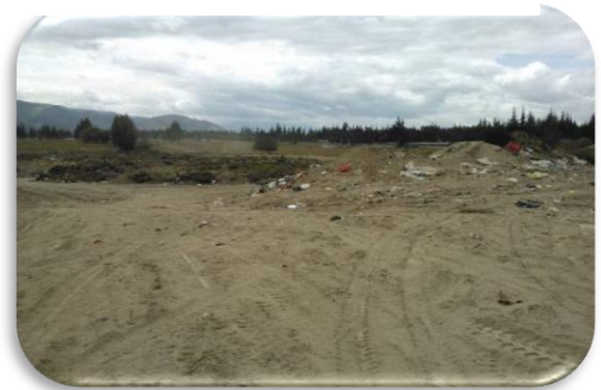
Fotografía N° 6 Lugar de trabajo relleno
