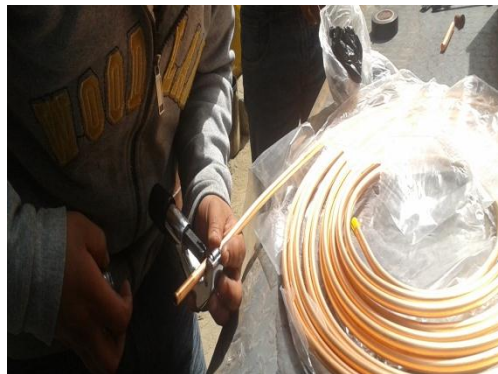
Figura 3.4 Corte de tubería
