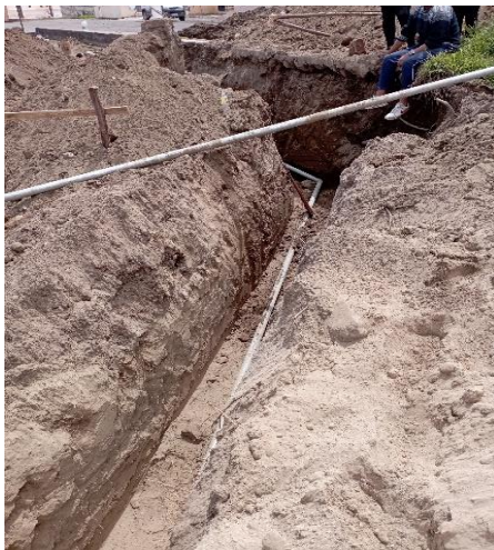
Figura 20 Inspección y diagnóstico del sistema de distribución de agua potable del Barrio Brazales
