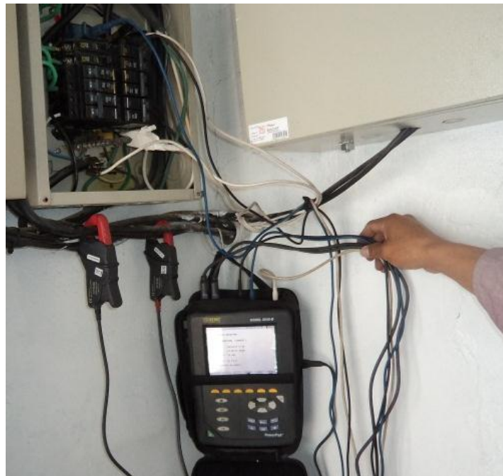
Figura 5. Instalación y programación del analizador de redes.
