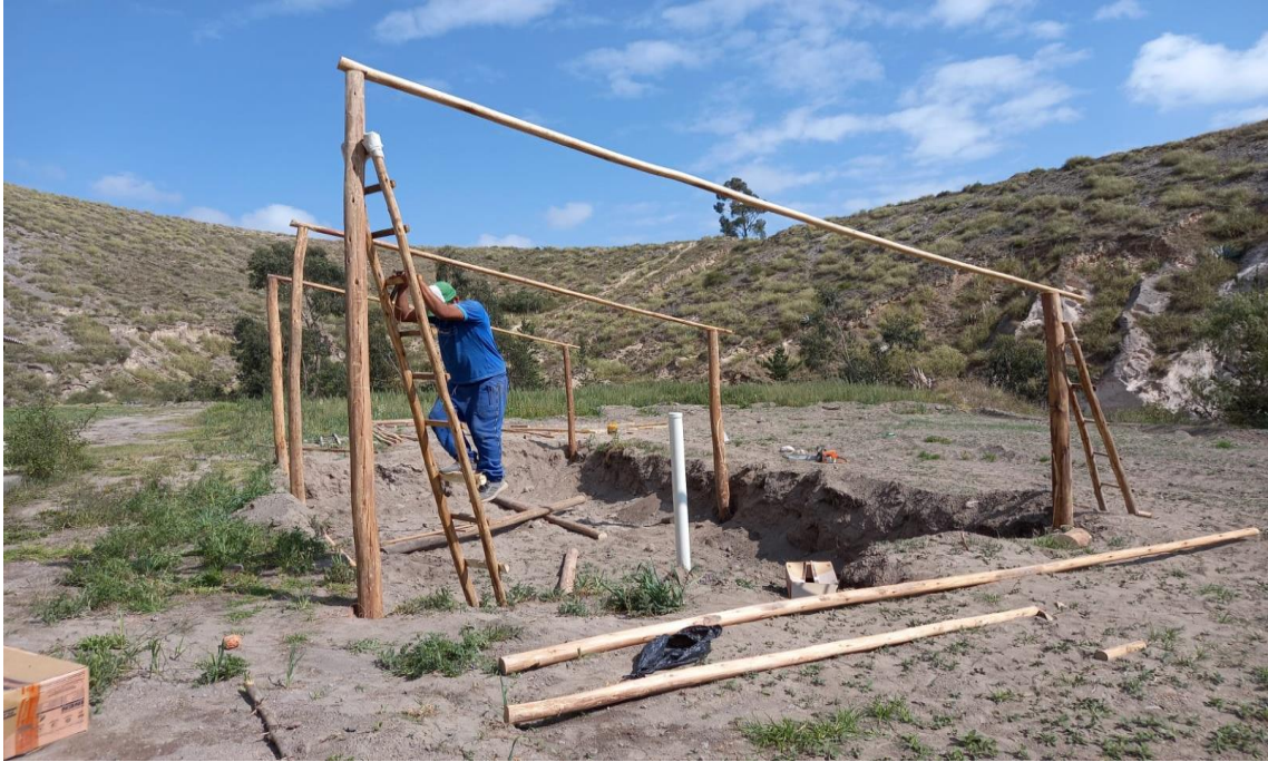
Figura A.2.6. Construcción del invernadero
