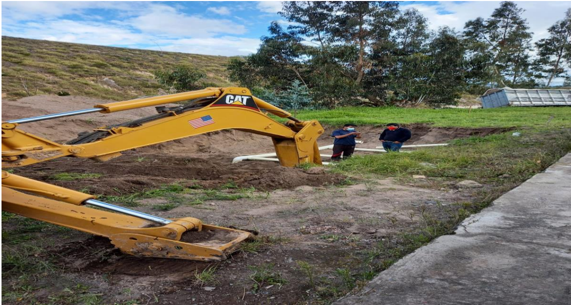
Figura A. 2. Excavación del área para el pozo canadiense
