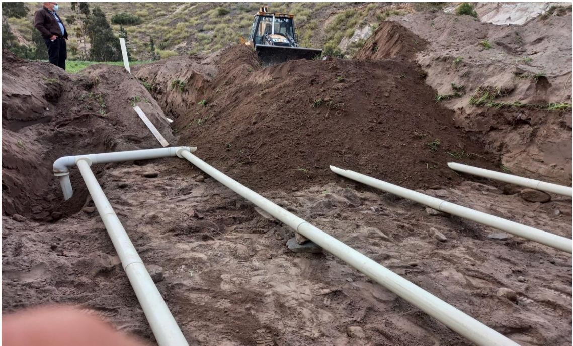
Figura A.2.3. Soterramiento de la tubería
