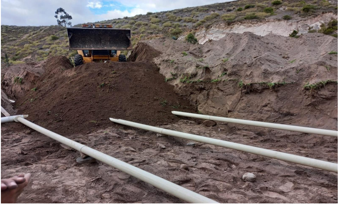
Figura A.2.4. Soterramiento de la tubería
