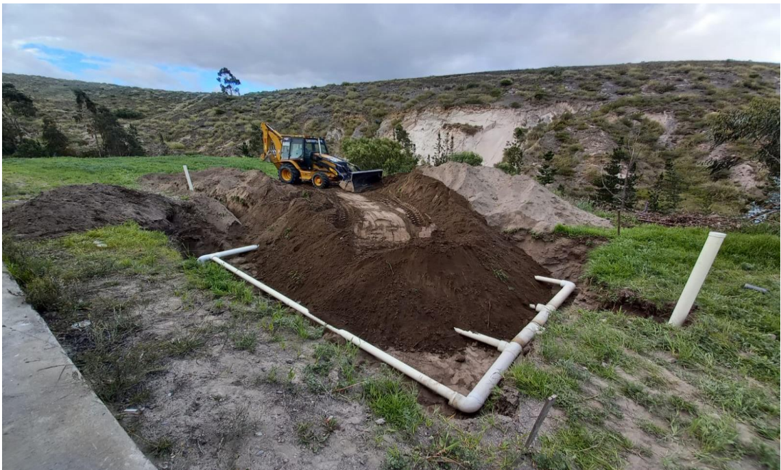
Figura A.2.5. Soterramiento de la tubería
