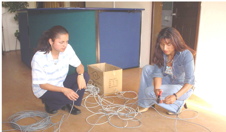
Figura 3.7: Cortado de Cable UTP
