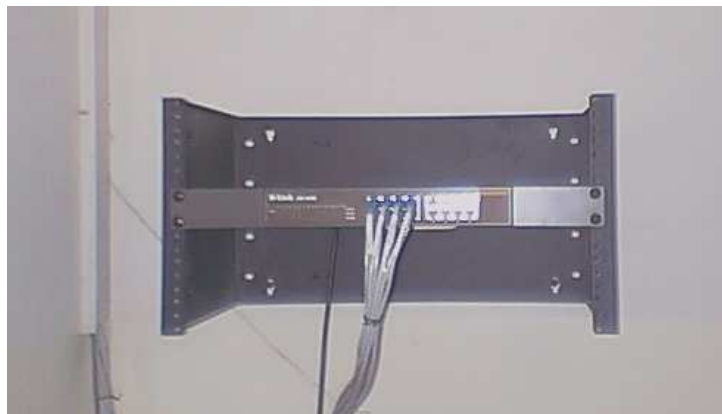
Figura 3.9: Armado del Switch y los Cables
