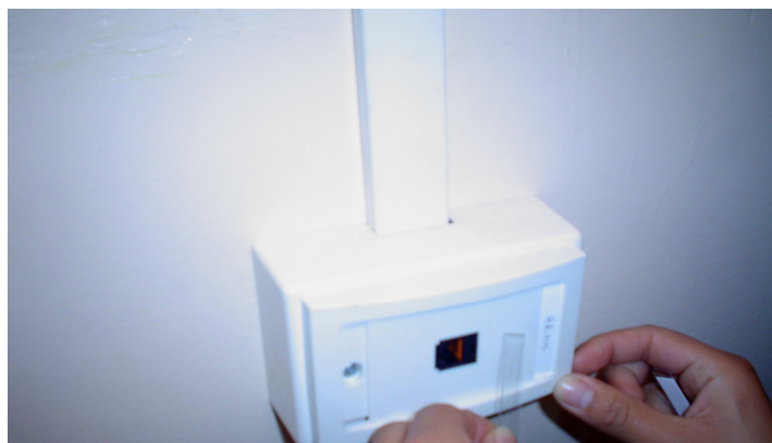
Figura 3.11: Etiquetado de los Puntos de Red.
