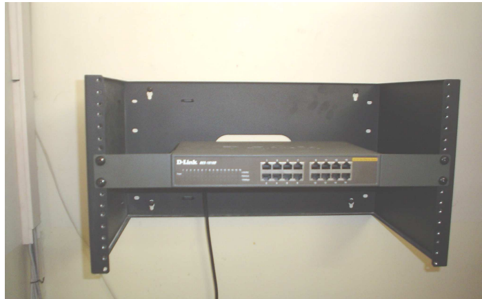
Figura 3.8: Armado del Rack.
