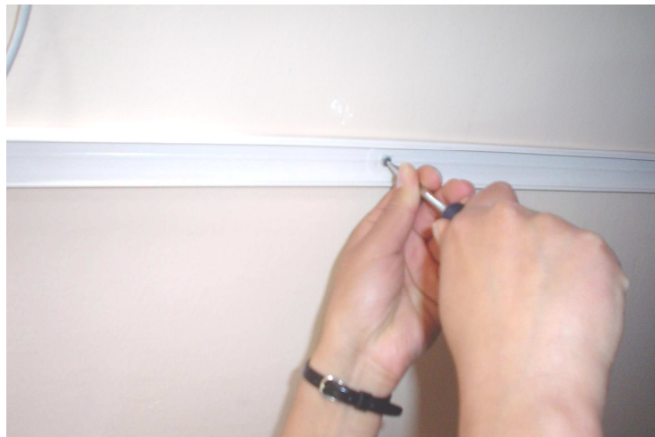
Figura 3.4: Colocación de Canaletas
