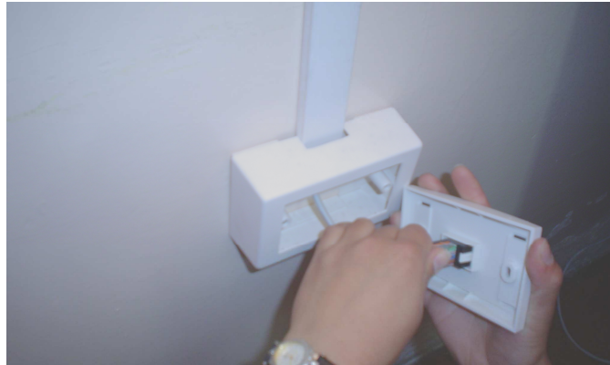
Figura 3.10: Inserción del Cable UTP en los Jacks.
