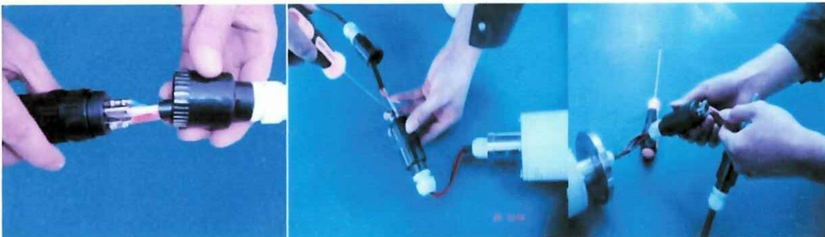
Gráfico 35. Preparación del equipo para los empalmes del cable flexible N° 10AWG
