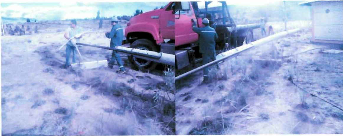
Gráfico 32. Elevación del poste para el acoplamiento de aspa del generador
