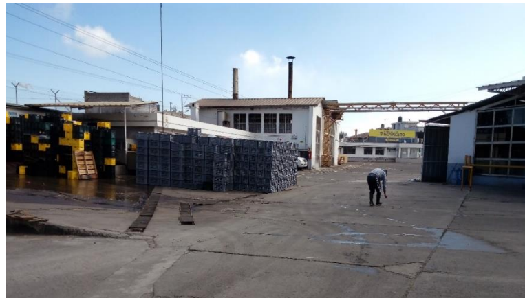
Figura 12. Zona externa de la planta Parmalat.
