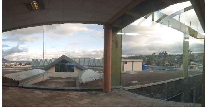
Figura 26. Azotea del Bloque B de la Universidad Técnica de Cotopaxi.
