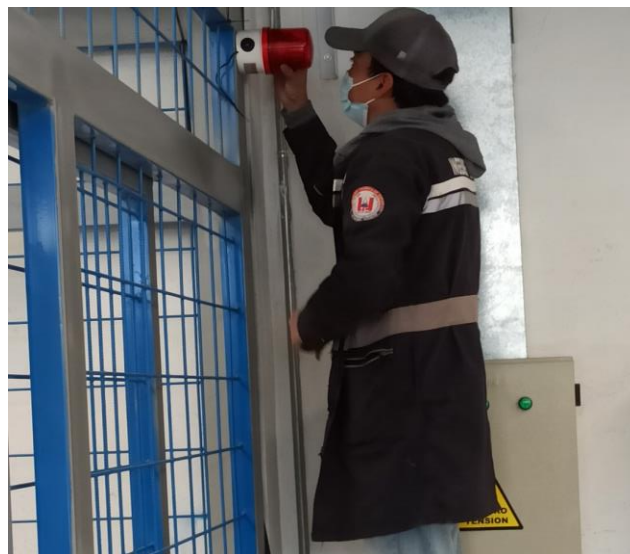
Figura E.11. Instalación de luces de advertencia.
