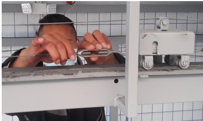
Figura 5.40. Regulación de la tensión del cable de acero en el eje x.
