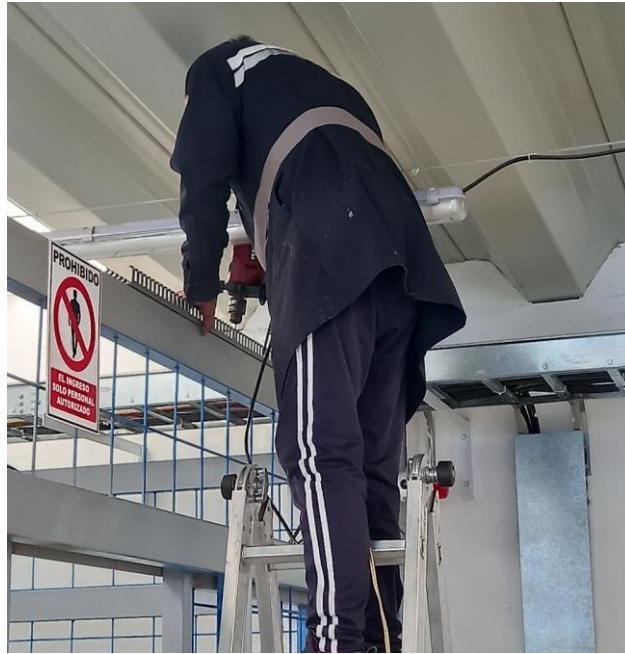
Figura E.7. Ubicación de canaletas en la Jaula de Faraday.
