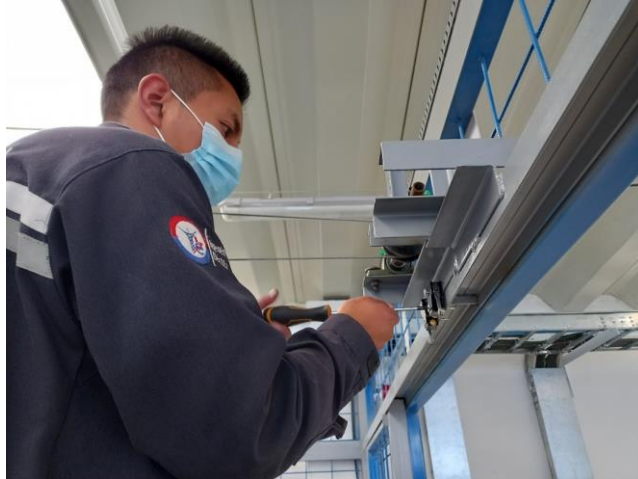
Figura E.9. Ubicación de finales de carrera.
