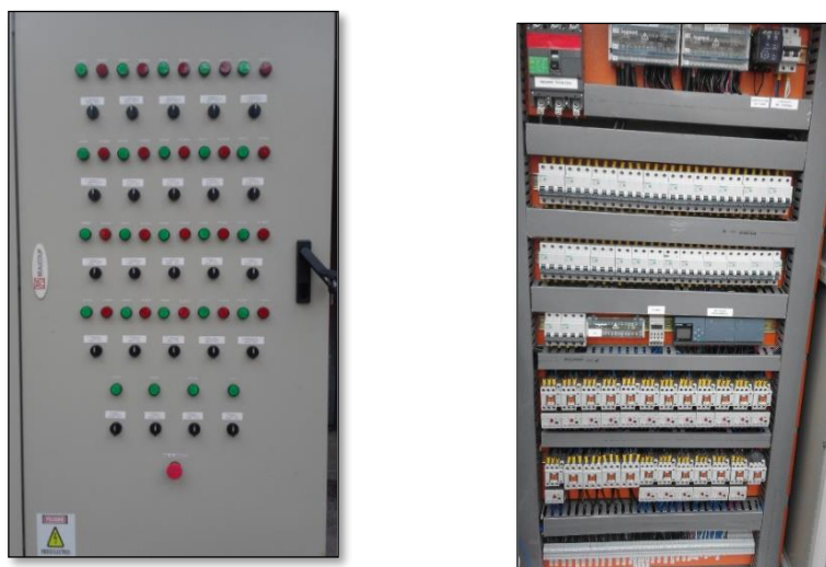
Figura 3 Tablero de control
