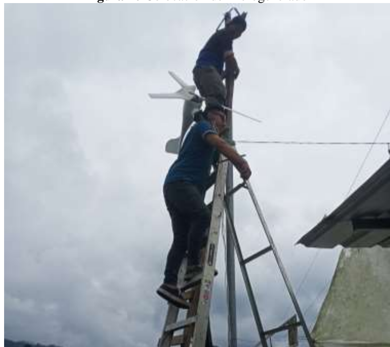
Figura 20 Colocación del Aerogenerador
