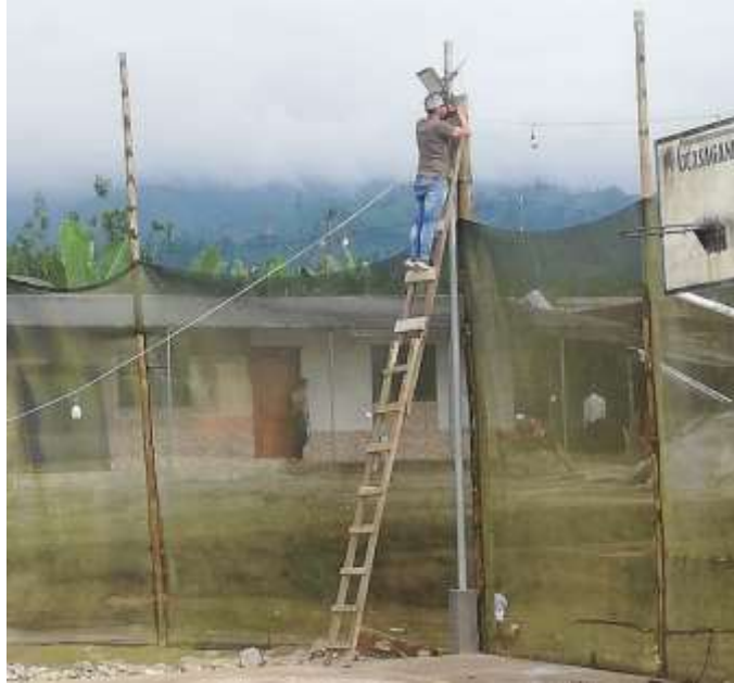
Figura 19 Colocación de los reflectores
