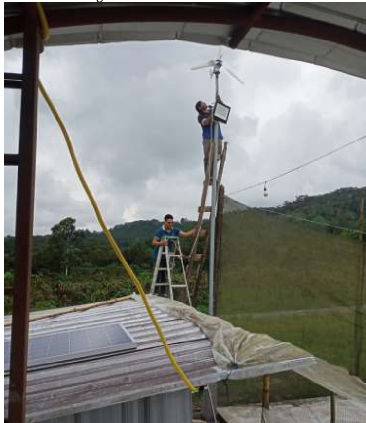
Figura 24 Generador eléctrico Híbrido
