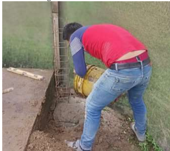
Figura 16 Colocación del mortero
