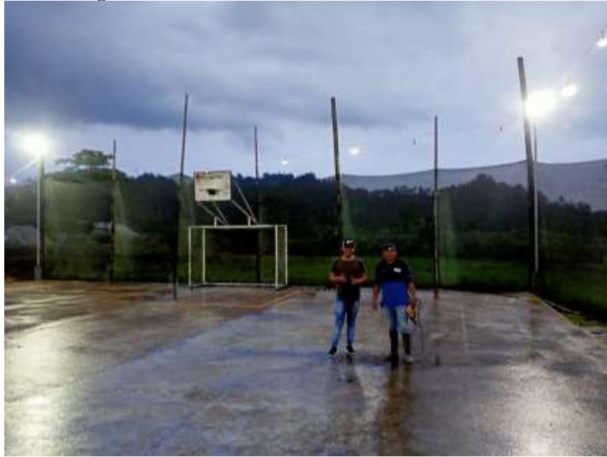
Figura 25 Iluminación de la Cancha en el recinto el Salento
