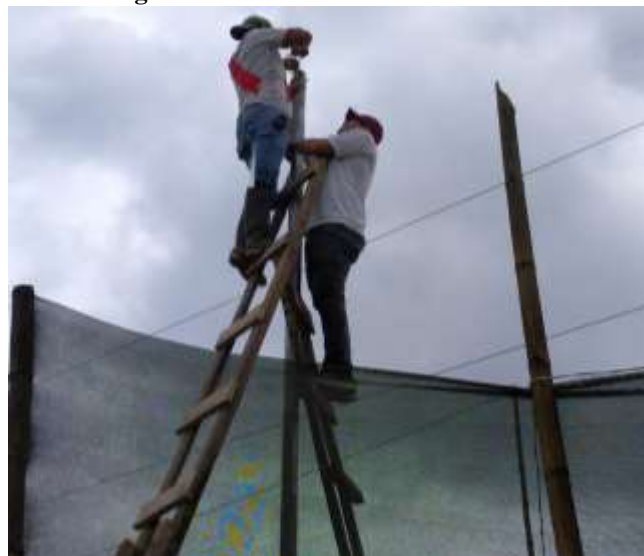
Figura 18 Colocación del cable eléctrico
