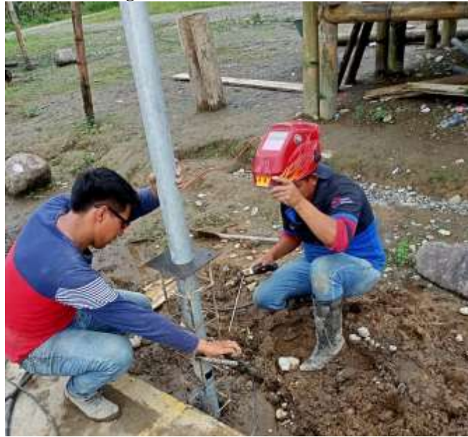
Figura 17 Colocación de los tubos
