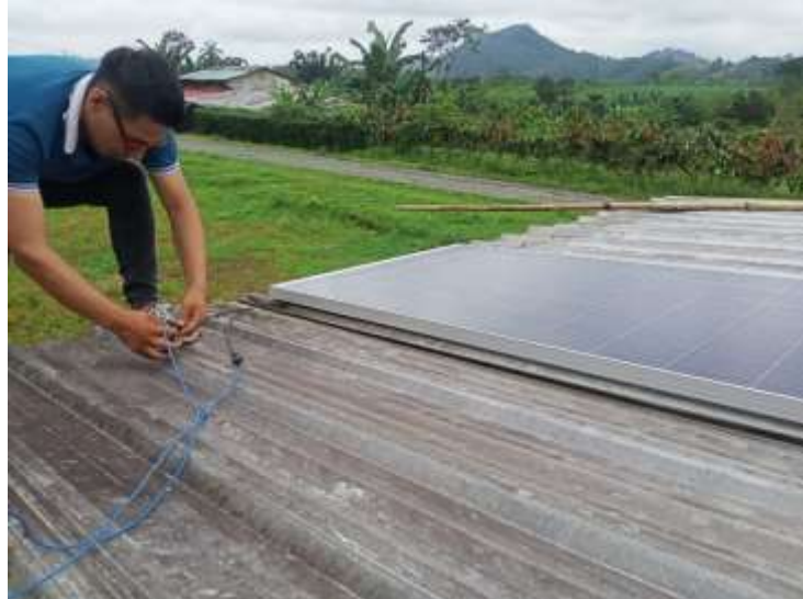
Figura 21 Ubicación del panel solar
