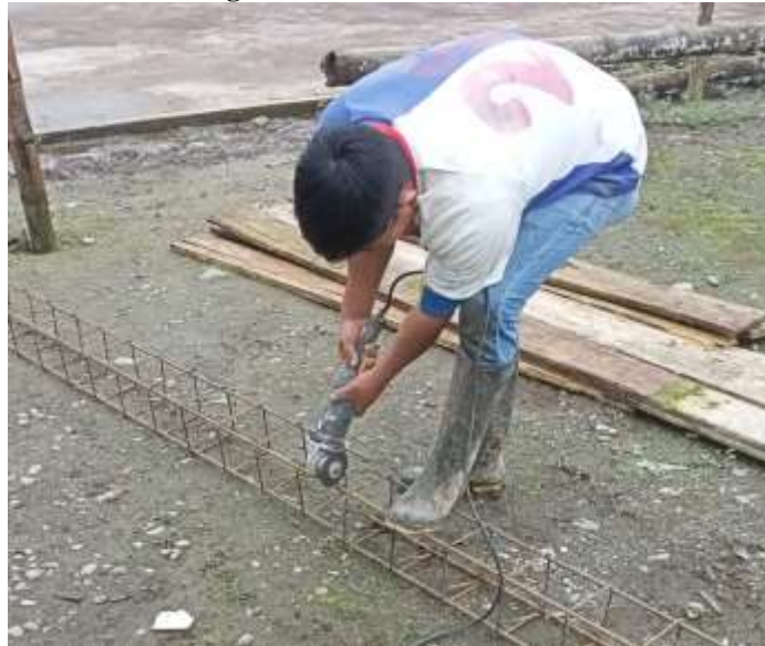
Figura 15 Armado de columnas
