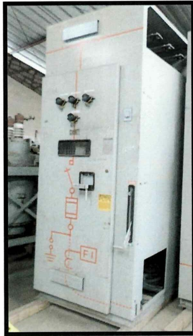
Figura No. 3.8 Seccionador Fusible
