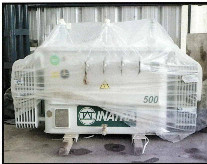
Figura No. 2.5 Transformador en Aceite
