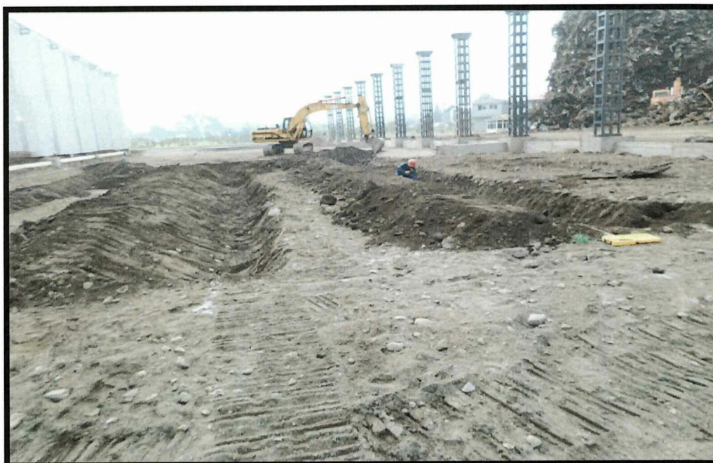
Figura No. 2.1 Espacio asignado para la construcción de cámara de transformación eléctrica
