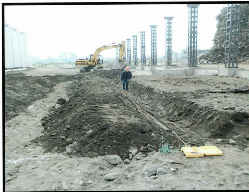
Figura No. 3.5 Medición con Telurómetro
