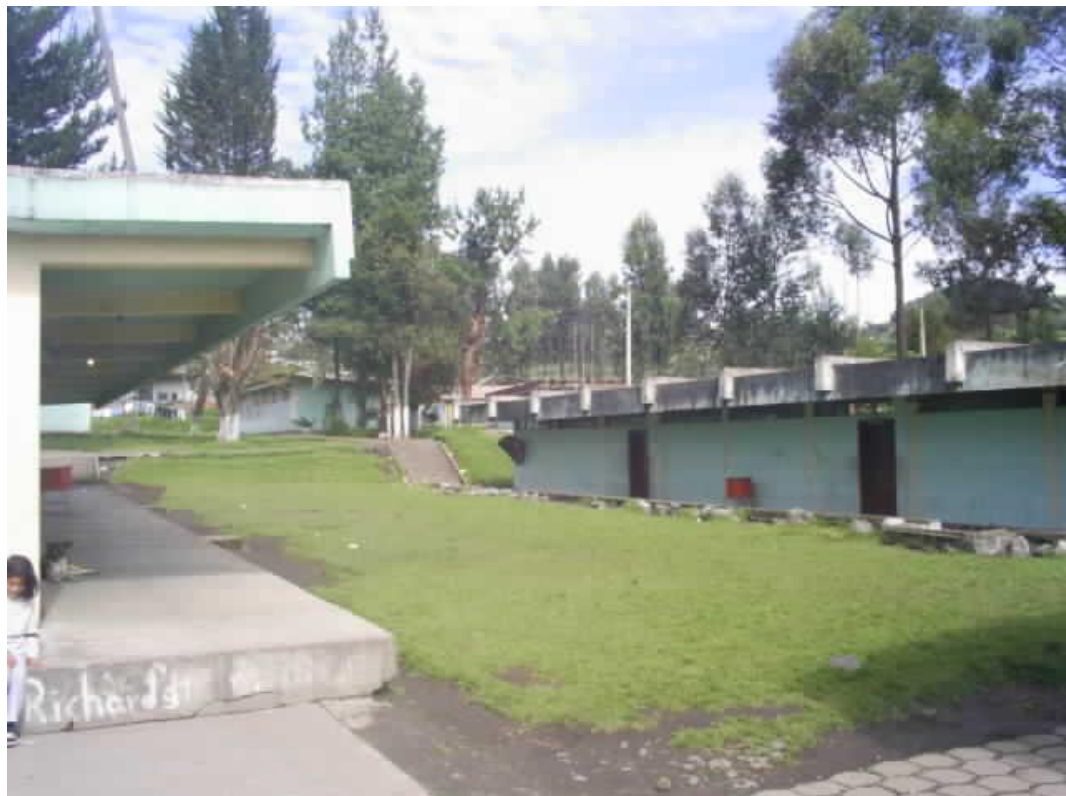
Bloque de Bachillerato del Colegio
