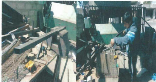
FIGURA 3.19. CORTE DE LA TUBERÍA DE 1”
