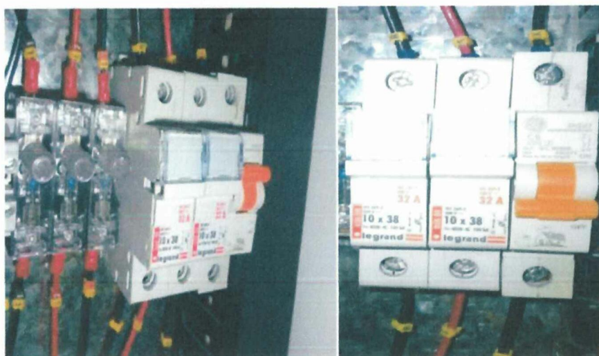
FIGURA 3.16. PORTA FUSIBLES Y BREAKER DE 1 POLO
