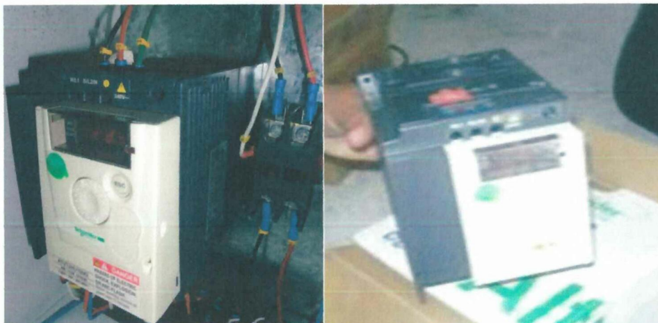
FIGURA 3.13.VARIADOR DE FRECUENCIA
