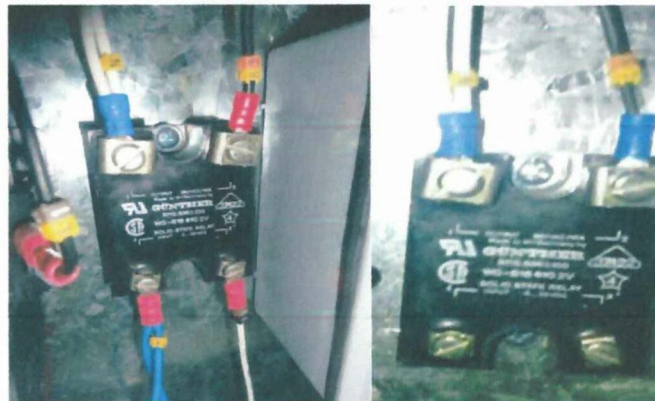
FIGURA 3.8.RELAIS DE ESTADO SÓLIDO
