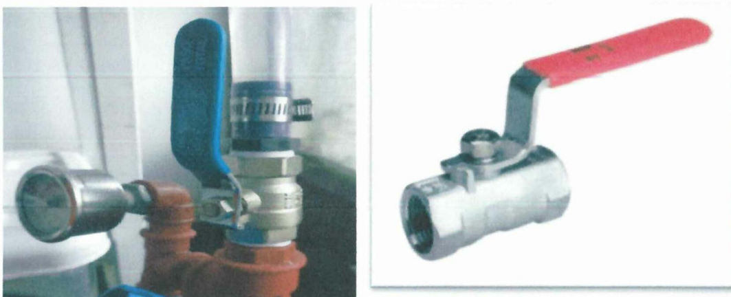
FIGURA 3.18. VÁLVULA DE BOLA
