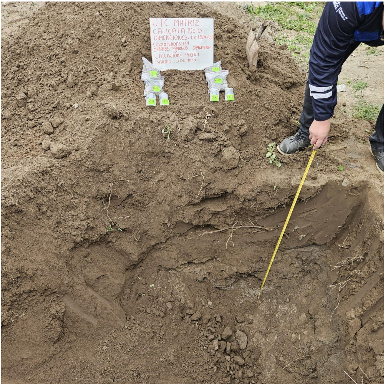
Anexo 20. Observación calicata N°6 en el sector 3 Mayo - Pujili
