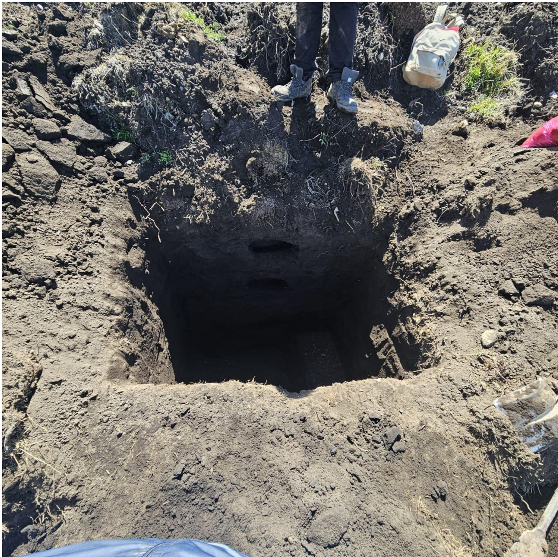
Anexo 1. Excavación de la calicata en el sector Apagua
