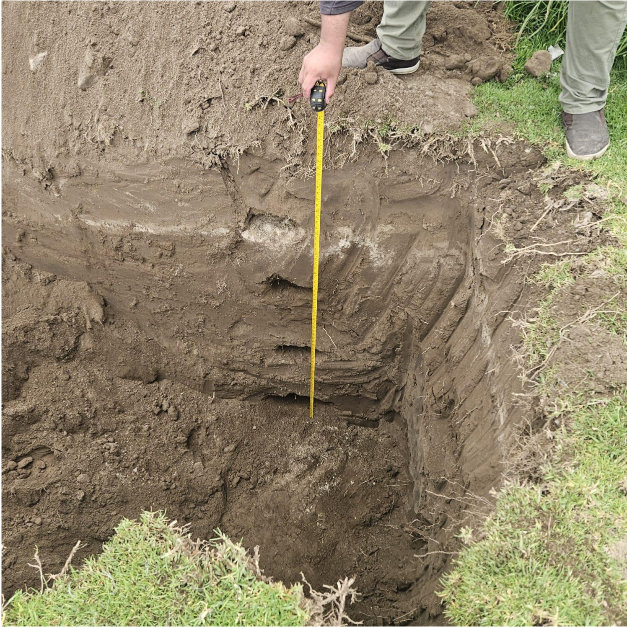
Anexo 40. Medición de profundidad de calicata N°12 en el sector La Victoria
