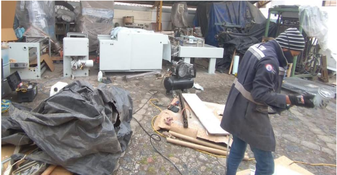
Figura I. 3. Pintado de máquina selladora de fundas.
