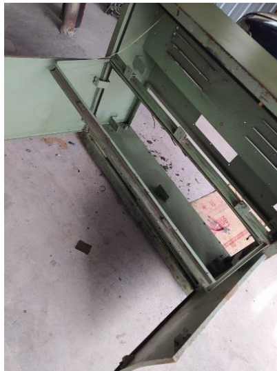
Figura 5. 9. Limpieza y Adecuación del gabinete.
