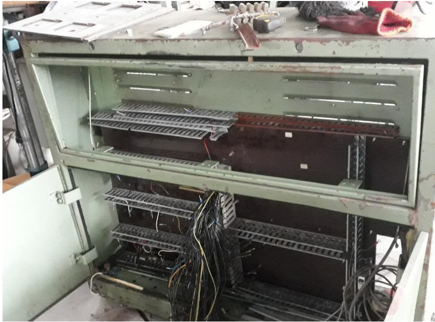
Figura IV. 1. Limpieza del tablero eléctrico.
