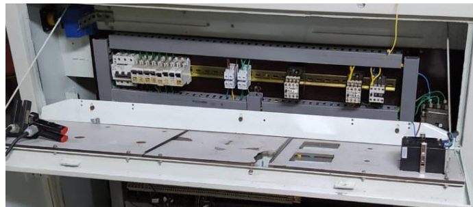
Figura 5. 11. Instalación de los componentes eléctricos.
