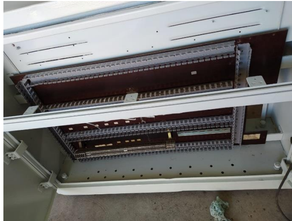
Figura 5. 10. Instalación de canaletas y riel din en el gabinete.
