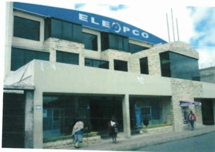
FIGURA 29: Edificio ELEPCO S.A.
