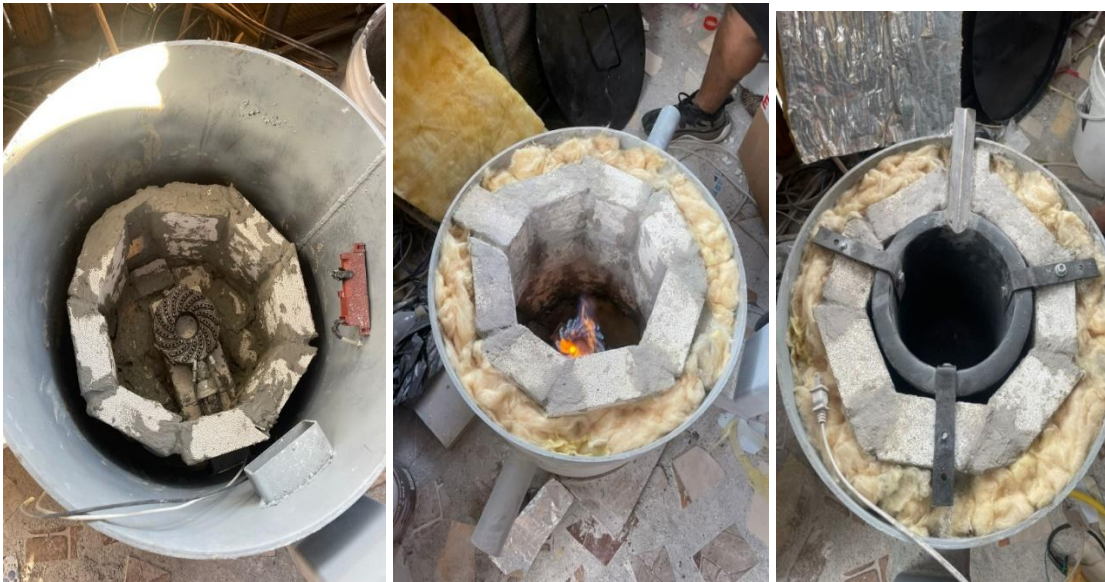
Figura 4.15 Instalación de ladrillos y concreto
