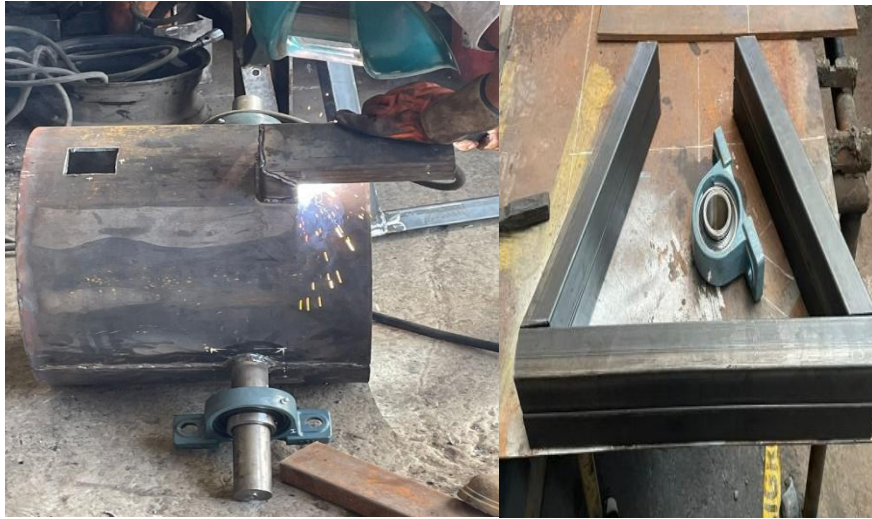
Figura 4.13 Soldadura de chimenea
