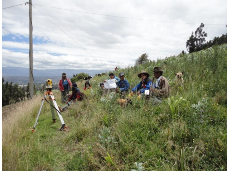
Levantamiento topográfico con la comunidad (01/04/2011).
