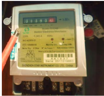
Figura 3.10. Medidor Electrónico con contador ciclométrico.
