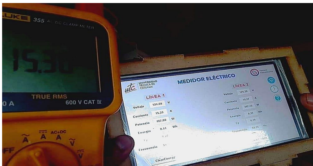
Figura 5.18. Corriente obtenida por los sensores y la pinza amperimétrica (Línea 1).
