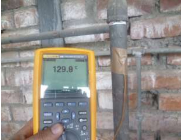
Ilustración 21: Medición de las pérdidas de energía en las tuberías
