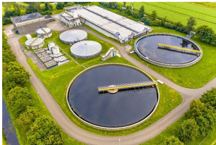
Figura 3. 2 Planta de tratamiento Agua Potable [17]
