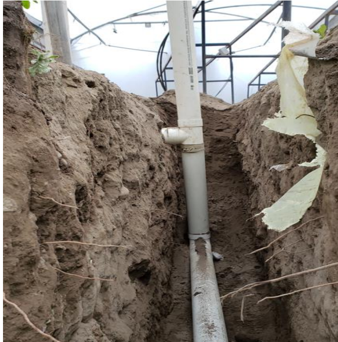
Figura 21. Acoplamiento de tuberías
