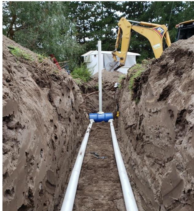
Figura 21. Acoplamiento de tuberías
