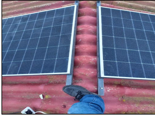
Figura 69. Instalación de soportes en la parte superior del techado.
