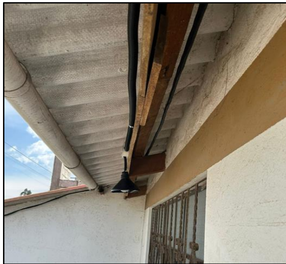
Figura 77. Colocación de lámparas colgantes de 9 Watts.
