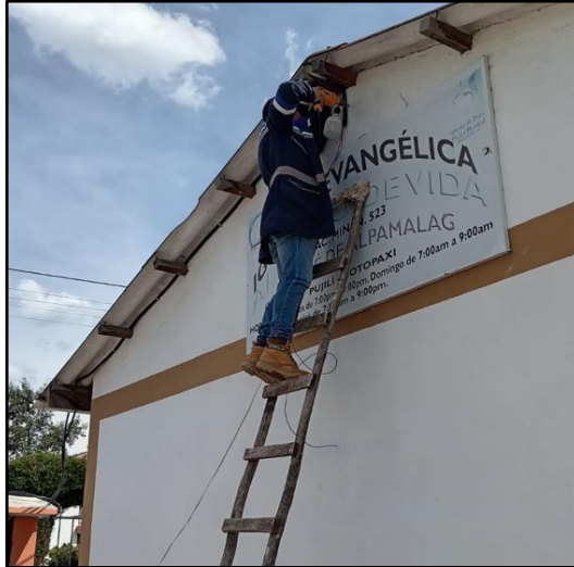
Figura 75. Colocación de manguera corrugada para luminarias externas.
