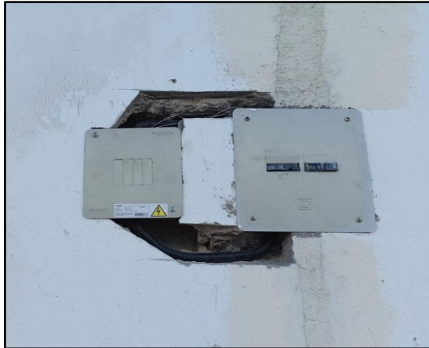
Figura 79. Empotramiento del tablero de distribución.
