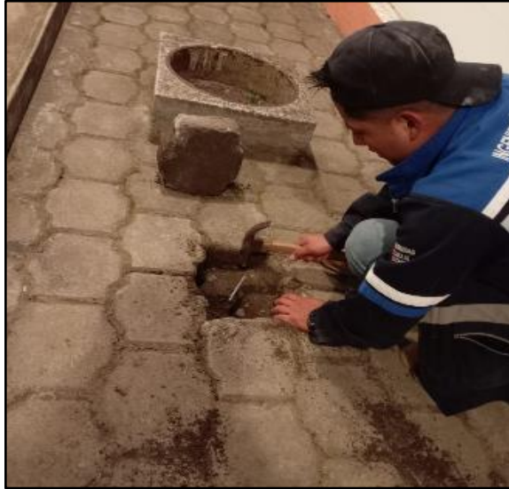
Figura 83. Colocación de las varillas para la prueba de resistividad del suelo.
