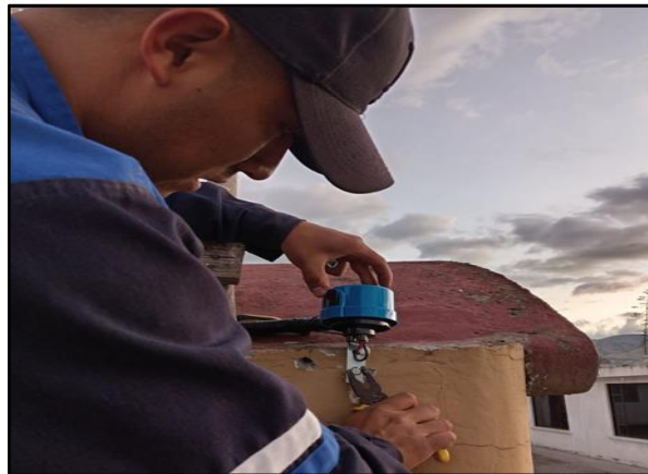
Figura 81. Instalación de la fotocelda al sistema de iluminación externa.
