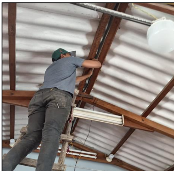
Figura 66. Colocación de manguera corrugada para la instalación eléctrica.
