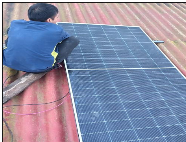
Figura 68. Instalación de estructura y paneles solares.
