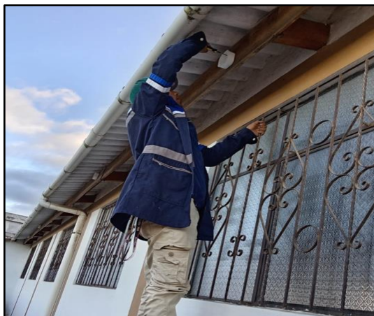
Figura 74. Instalación de cajetines de paso para luminarias exteriores.
