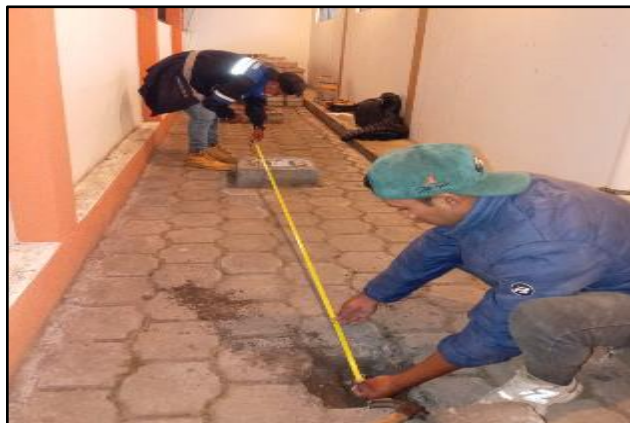
Figura 82. Medición para la colocación de electrodos tipo varilla.
