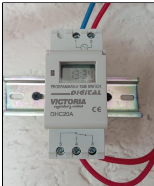
Figura D. Temporizador digital Victoria DHC20A.
