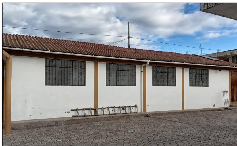
Figura 78. Vista panorámica del área de instalación de luminarias externas
