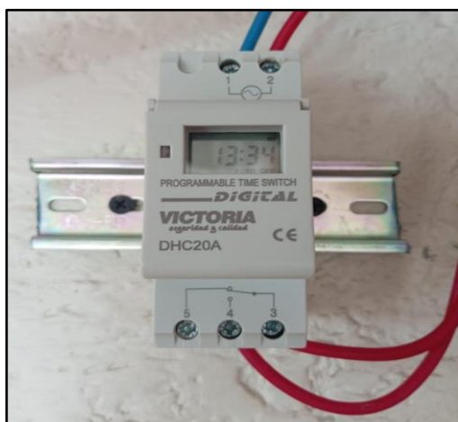
Figura 125. Instalación del temporizador digital.
