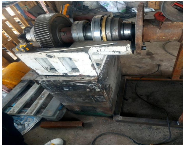
Figura 5.25 Instalación de la caja reductora sobre su soporte
