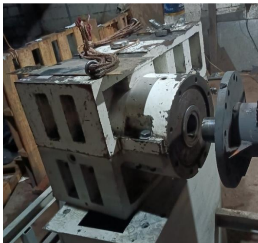
Figura 5.29 Montaje de la caja reductora
