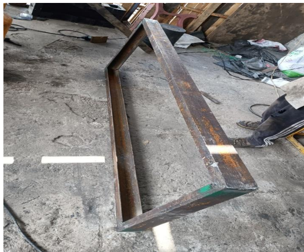
Figura 5.21 Proceso de fabricación del soporte estructural
