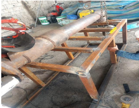
Figura 5.26 Instalación del cilindro
