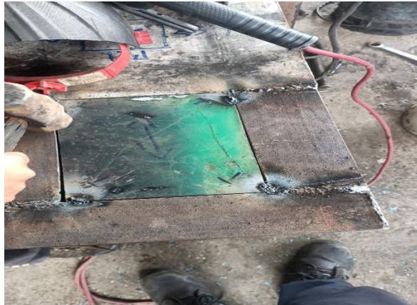
Figura 5.24 Fabricación del soporte para la caja reductora
