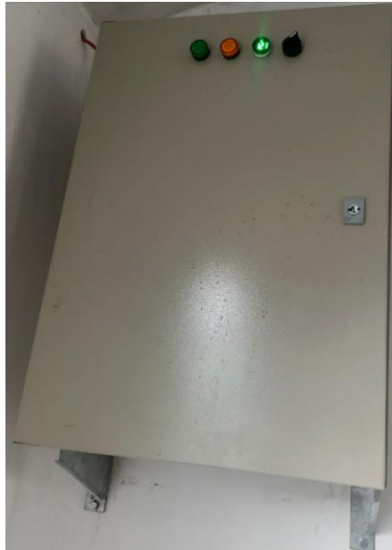
Figura 26 Gabinete metálico de 70x50x25 cm.
