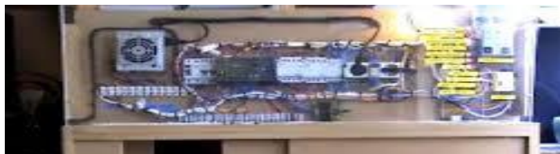
FIG N.- 4 MANIOBRA DE MAQUINAS
