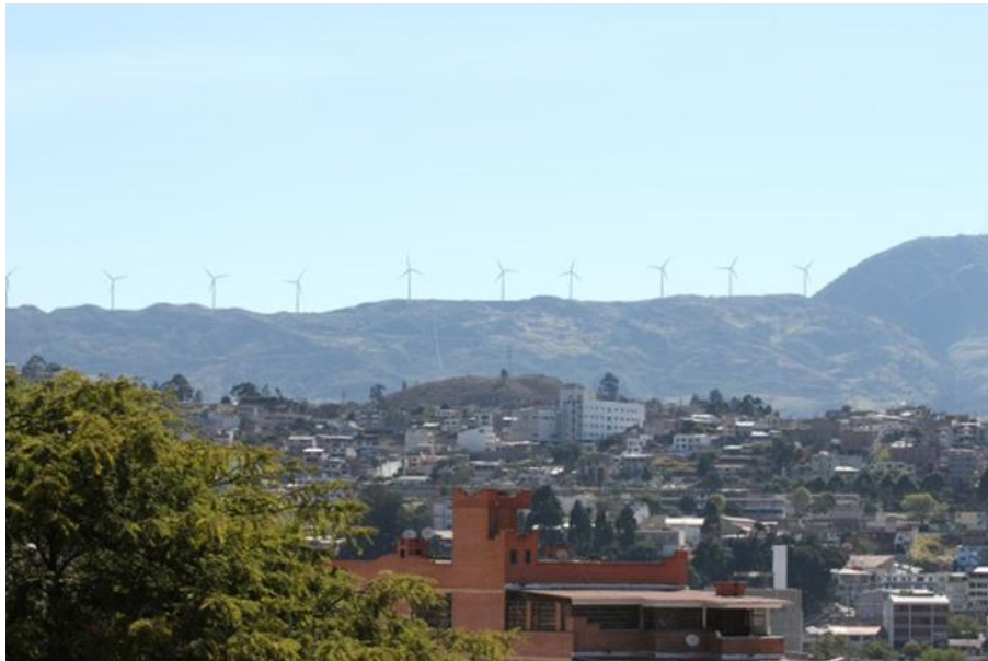
Figura 17. Aerogeneradores del Parque Eólico Villonaco Se investigó la ficha técnica del Parque Eólico Villonaco, Tabla 7 , en la misma se obtuvo datos de la potencia total y longitud de aspas.
