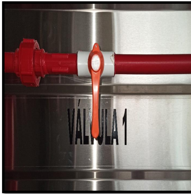
Figura 2. Válvula cerrada
