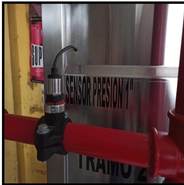
Figura 15. Sensor de presión
