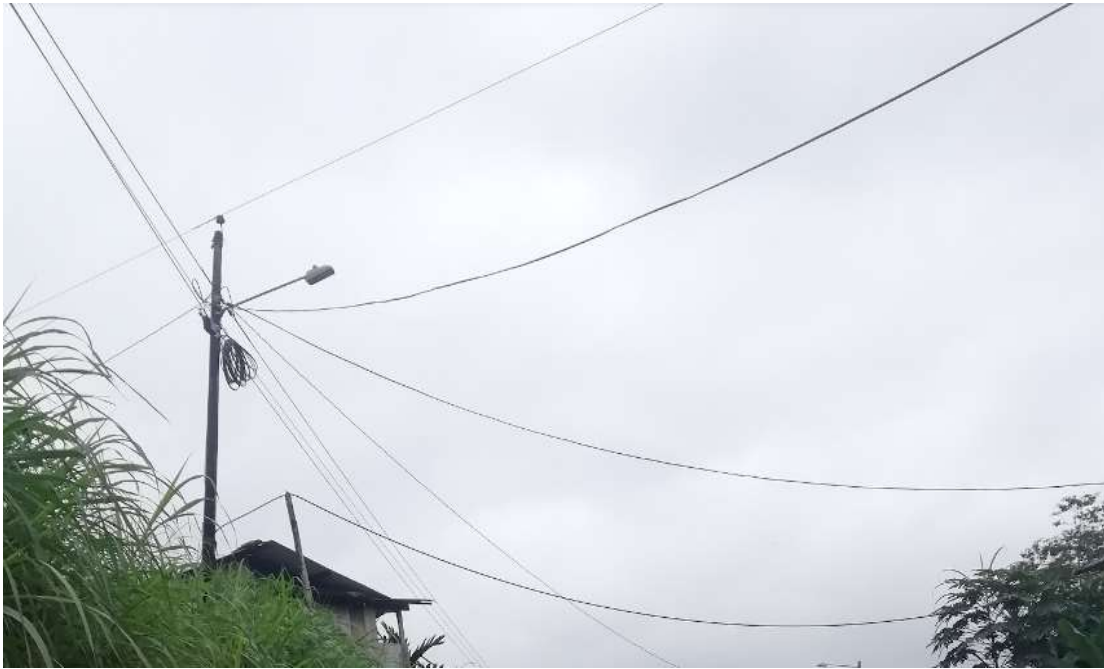
Ilustración 6. Levantamiento de vanos que no disponen neutro en la red monofásica del alimentador Pita
