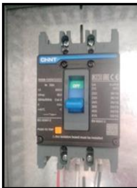
Figura 4.9. Protección general del tablero
