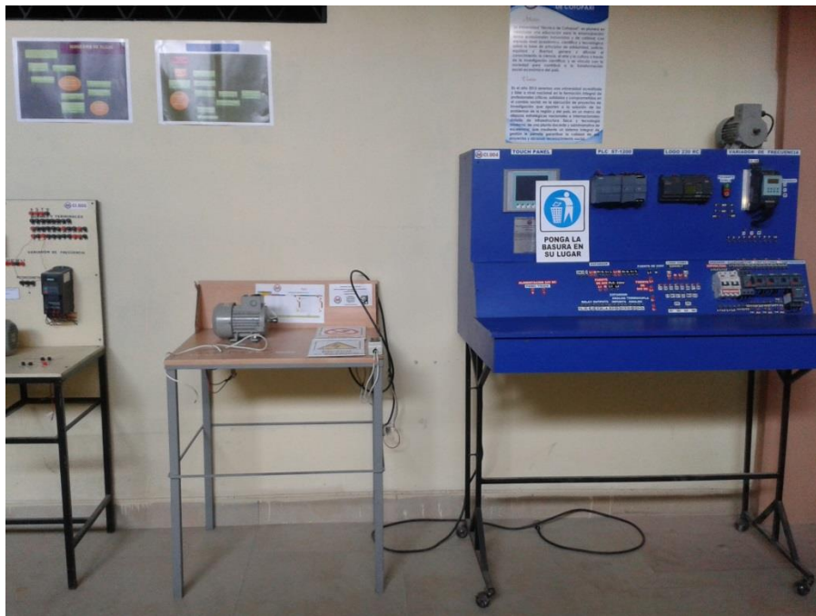
Gráfico No. 17 SITUACIÓN DEL LABORATORIO DE ELÉCTRICA
