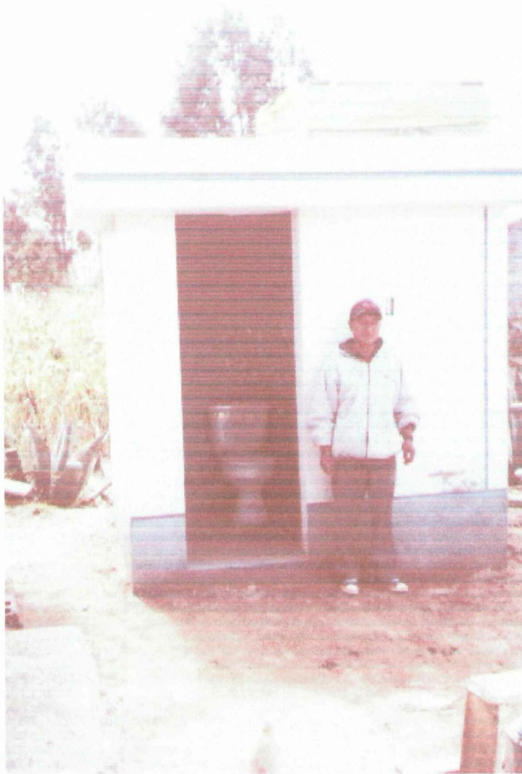
Construcción de servicios higiénicos familiares
