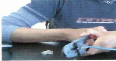
Gráfico N° 25 Ponchado del cable UTP
