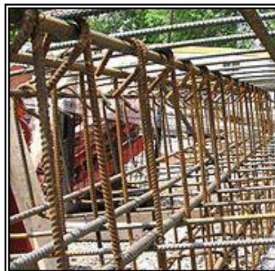
Figura 1.5 Varilla Corrugada- Fuente: Construcción Subestación
