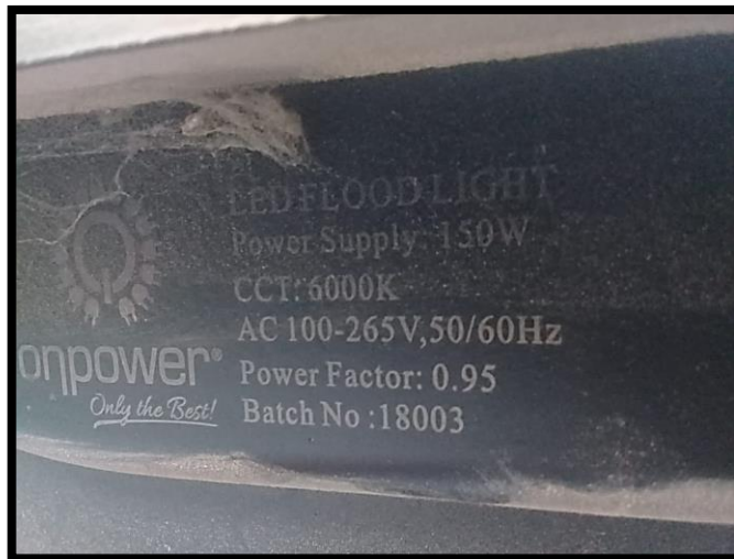
Figura 39. Placa de datos de las luminarias
