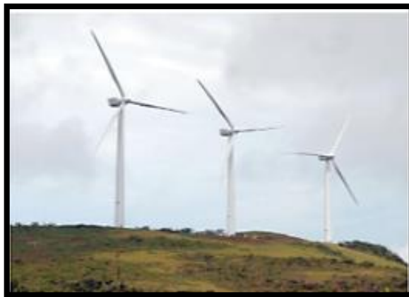
Figura 5. Parque Eólico Villonaco [11].
