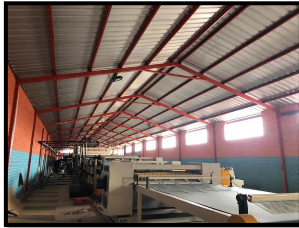
Figura 45. Maquinaria y materia prima fábrica Yaron.
