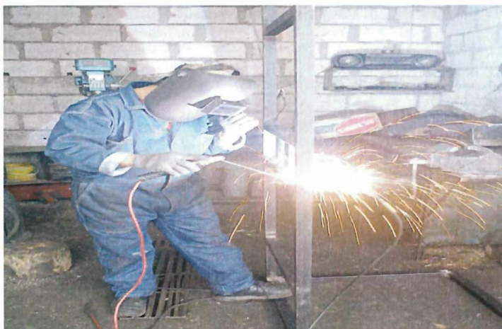
UNIÓN DE LA ESTRUCTURA POR EL PROCESO DE SUELDA ELÉCTRICA.
