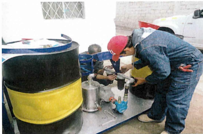
UNIÓN DE LA MOTOR-BOMBA Y FILTROS EN LA ESTRUCTURA
