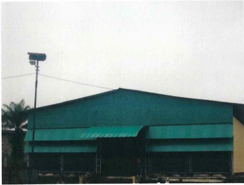
FOTOGRAFÍA No. 05.- FACHADA LUEGO DEL TRABAJO EJECUTADO
