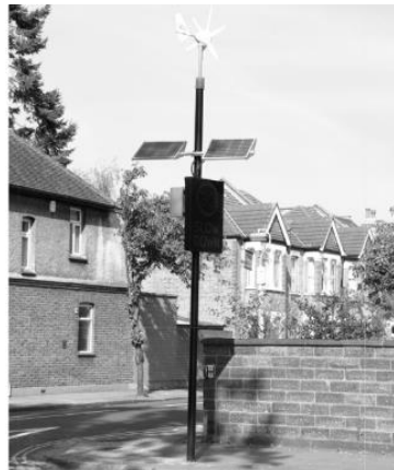
Figura 3. 6.- Instalación solar fotovoltaica con sistema de apoyo eólico [21].
