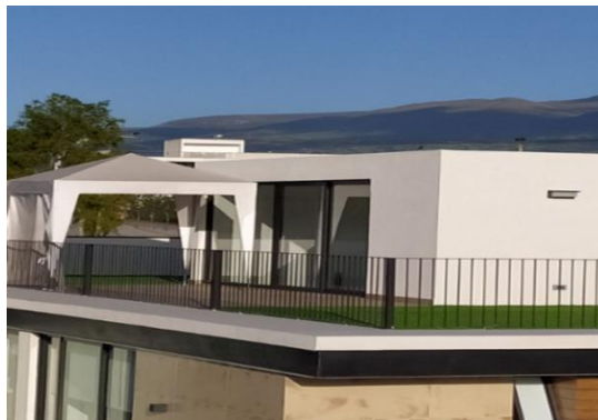
Figura 5. 2.- Techos de la residencia Carob.
