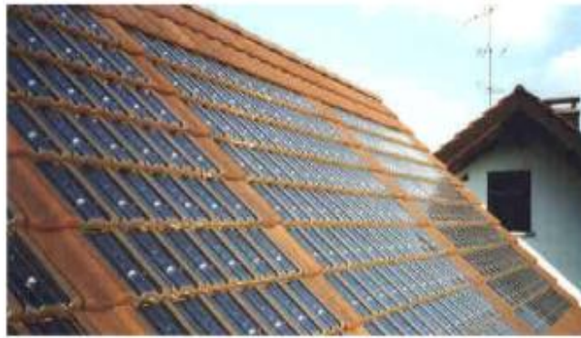
Figura 3. 2.- Tejado con panel solar amorfo [20].
