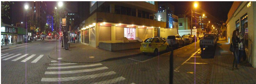
Figura 5.1. Iluminación de vías con luminarias LED y VSAP.
