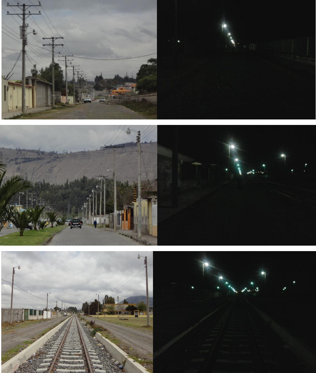
Figuras 3.5.a, 3.5.b, 3.5.c y 3.5.d. Urbanización Rumipamba de las Rosas. Vista en el día y vista de la iluminación en la noche.
