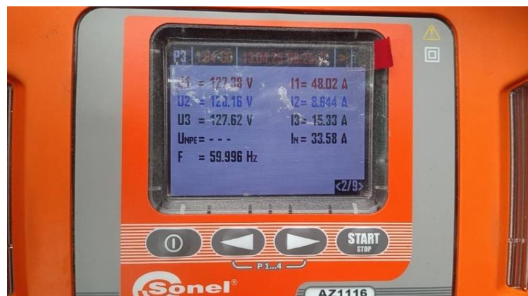
Figura 10. Analizador de red.
