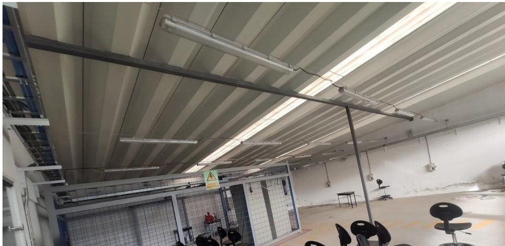
Figura 48. Estructura metálica del laboratorio.
