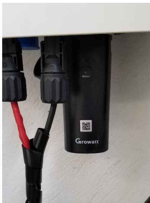
Figura X.2: Data logger SHINE WIFI-X conectado al inversor.
