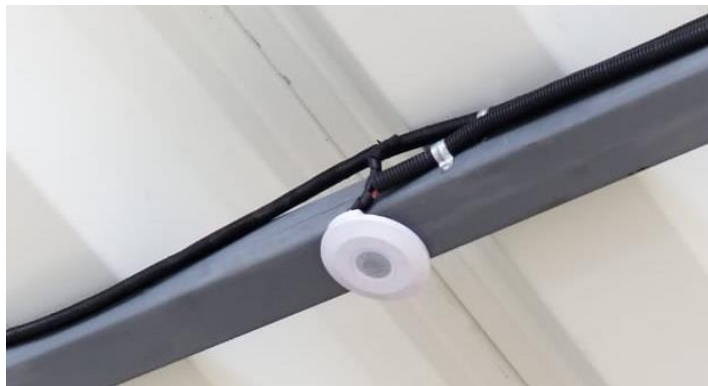
Figura 63. Ubicación del sensor de movimiento 2.
