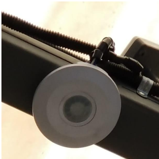
Figura 62. Ubicación del sensor de movimiento 1.
