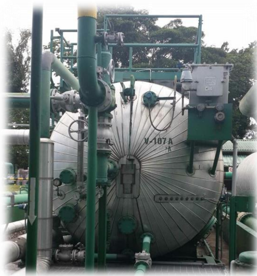
Figura 2.19. Transformador deshidratador electrostático
