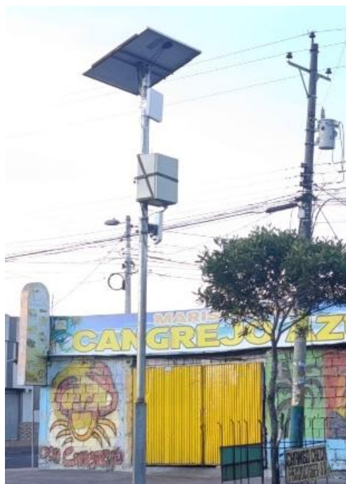
Figura 4.30. Estación RFID con lector integrado y antena adicional
