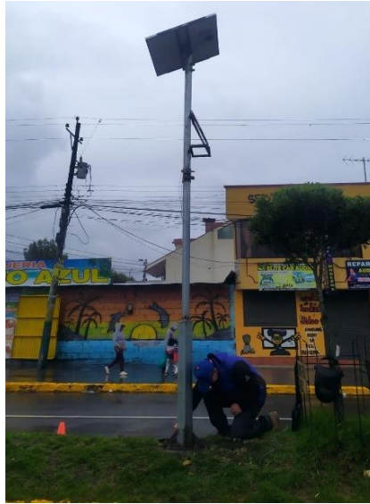
Figura 4.7 Estructura instalada en el cantón Saquisilí
