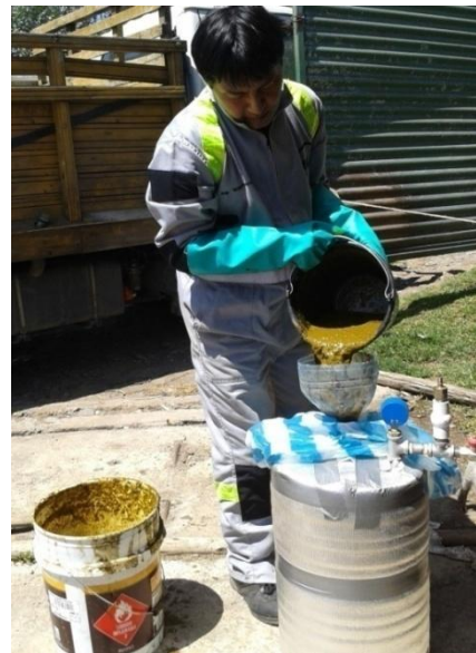
Llenado de los tanques biodigestores.
